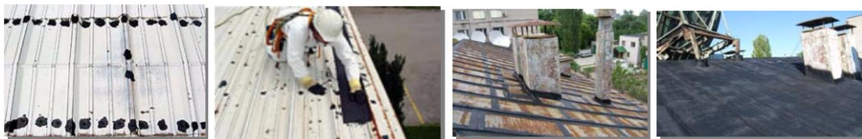
Отверстия можно обнаружить по протечкам, появляющимся после сильного дождя. Выявив дефектные места, приступают к их ремонту. Заделка дефектов кровли производится в следующей последовательности: сначала мастикой [Trowel Rubber®](#) заделывают кромки кровли, трещины на фальцах и швах, затем накладывают заплаты на сквозные отверстия. После этого обрабатывают желоба и, наконец, всю поверхность кровли.
