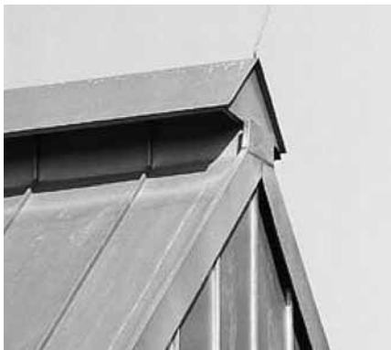
Фото 7.1: Узел соединения конька на фронтоне, высокий вариант
