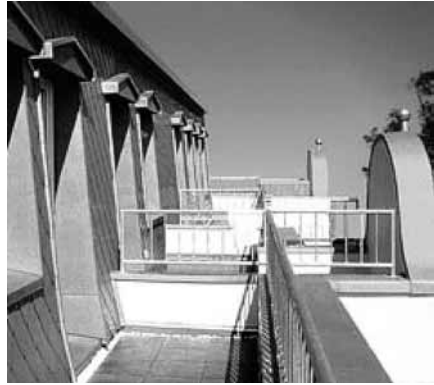
Фото 14.2: Использование RHEINZINK® - строительных профилей для покрытия парапетов
