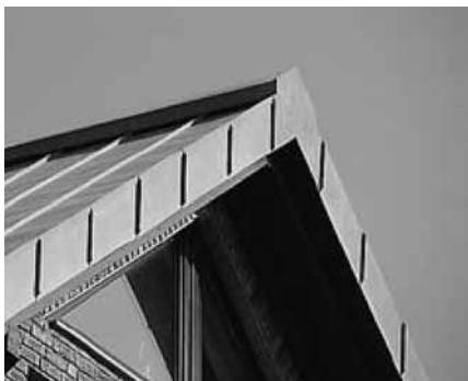
Фото 7.2: Узел соединения конька с ребром, низкий вариант
