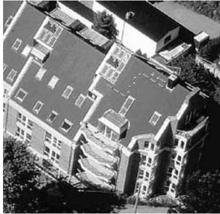
Фото 15: Отделка аттика и карниза
