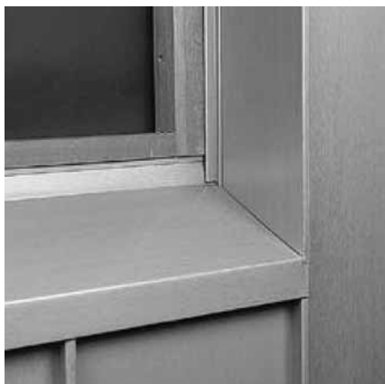
Фото 11: Оконный проём с боковым примыканием к парапету
