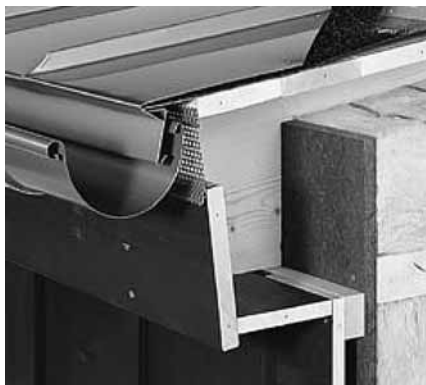
Фото. 5.1: Применение: узел карнизного свеса с желобом Техника стоячего фальца с применением ОДМ
