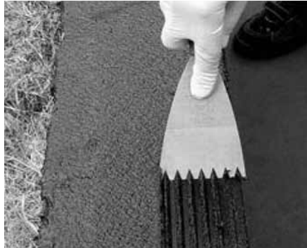
Фото 3.1: Enkolit® наносится гребенчатым шпателем
