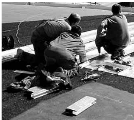
Фото. 5.3: Структурная мембрана без пленки, Enka®-Vent
